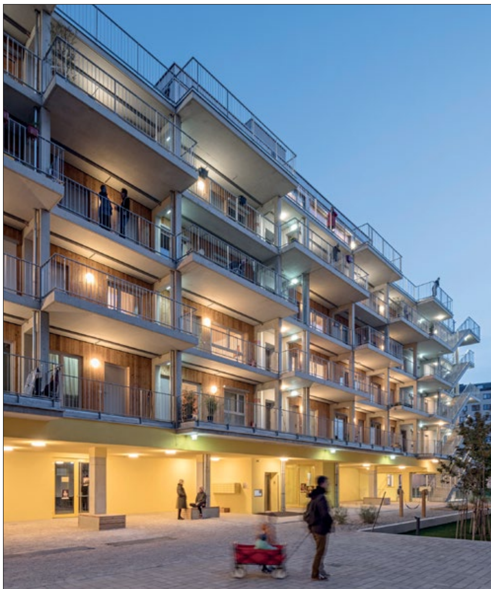
Der Materialmix und die vorspringenden Balkone am Laubengang setzen einen Kontrapunkt zur Monotonie der benachbarten Gebäude.
